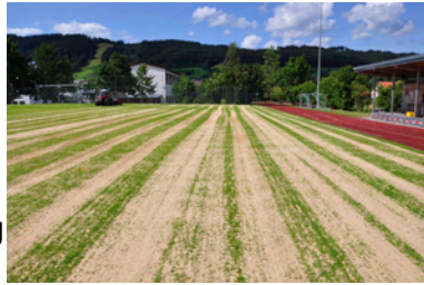
50 Tonnen Quarzsand wurden verteilt
