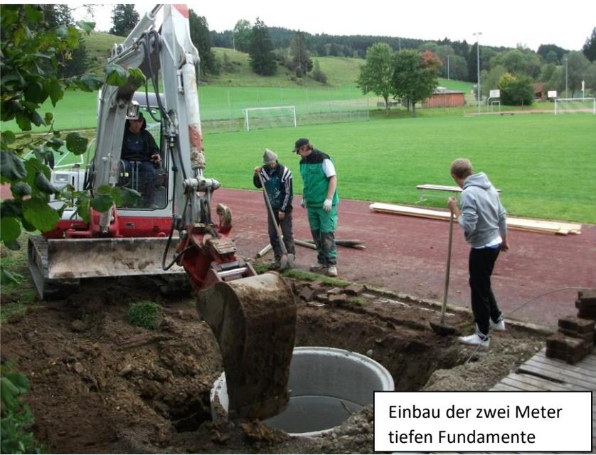
Einbau der zwei Meter tiefen Fundamente
